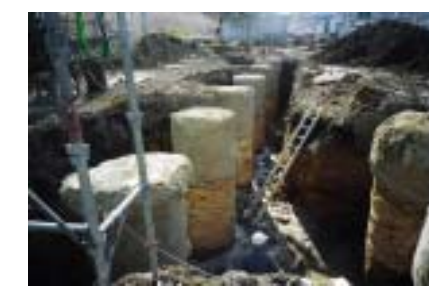
写真-2 改良体掘り起こし状況
